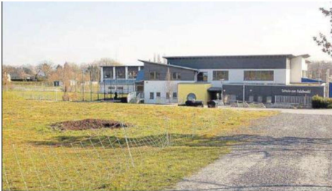
Auf der Wiese (links) vor der Schule am Adelwald wird eine Mensa entstehen. Ziel ist es, noch in diesem Jahr mit dem Bau zu starten. Zum Schuljahr 2017/18 soll die Mensa genutzt werden können. • Foto: Beuning
